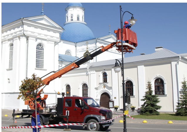
Работа под напряжением, аг. Жировичи
