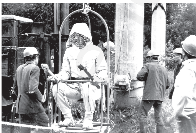
Бригада Ошмянского ПЭС выполняет замену гирлянды изоляторов на ВЛ 330 кВ Игнашинская АЭС – Молодечно под напряжением, 1988 год
